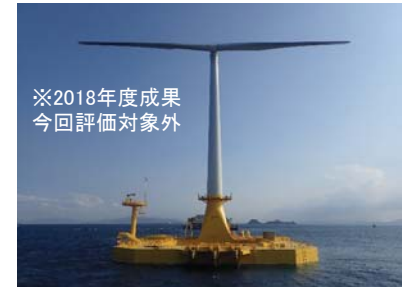
海域に係留接続完了した浮体式洋上風力発電システム「ひびき」
