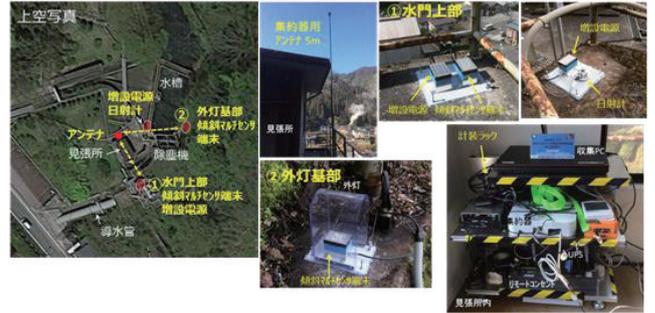
図9 水力発電所に設置した傾斜センシングシステム
