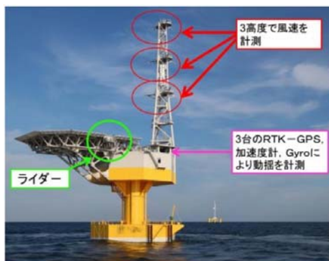
図 1.3-8 福島沖浮体式洋上風況観測タワー 12
