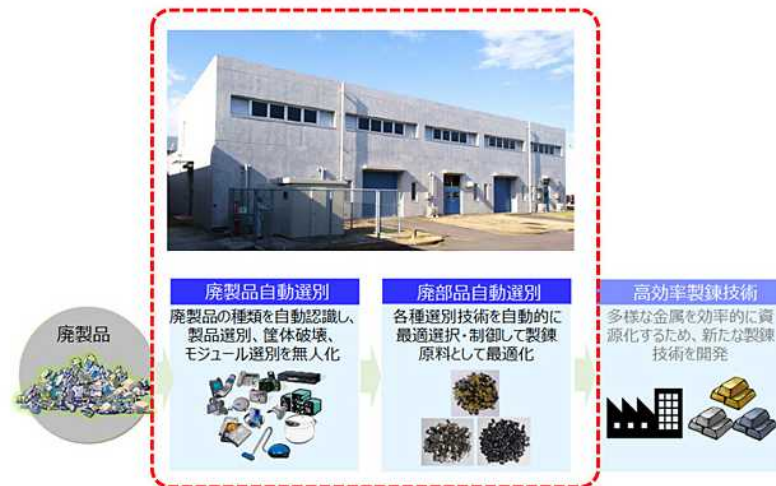
図1 集中研究施設「CEDEST」の外観と同施設で開発する技術
