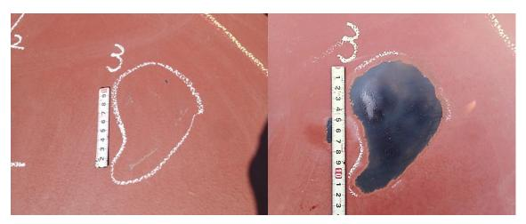
図Ⅲ2.1.1.1-20 塗装を剥離する前の損傷状況と塗装剥離後の母材損傷状況
