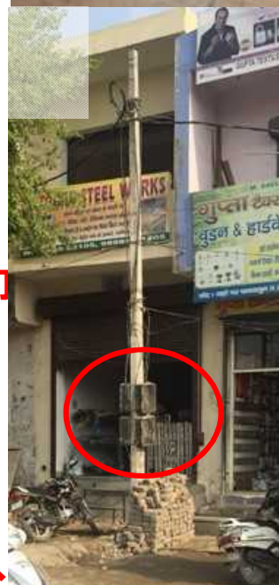
メータの柱上設置
