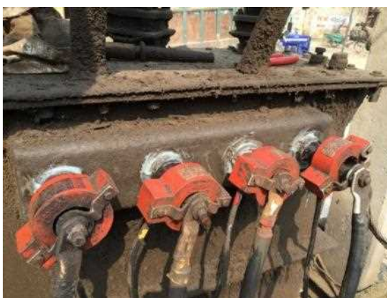
柱上変圧器の現地補修作業
