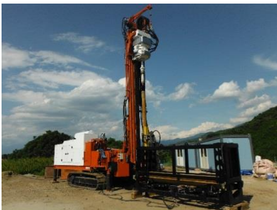
写真Ⅲ (1.2)-1 掘削機
