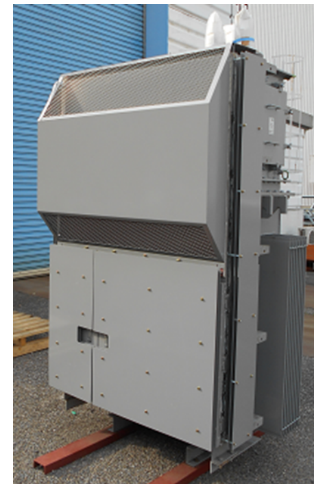
50Hz試作機 (300kVA, SiC使用)
