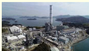
高効率火力発電所
