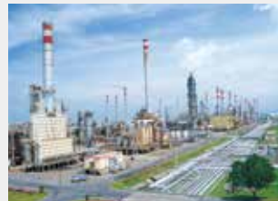
実証サイト(プラタミナ製油所)
