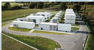
大規模ハブリッド蓄電池システム実証（ドイツ）
