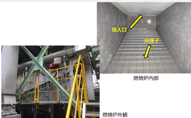
写真3 燃焼炉
