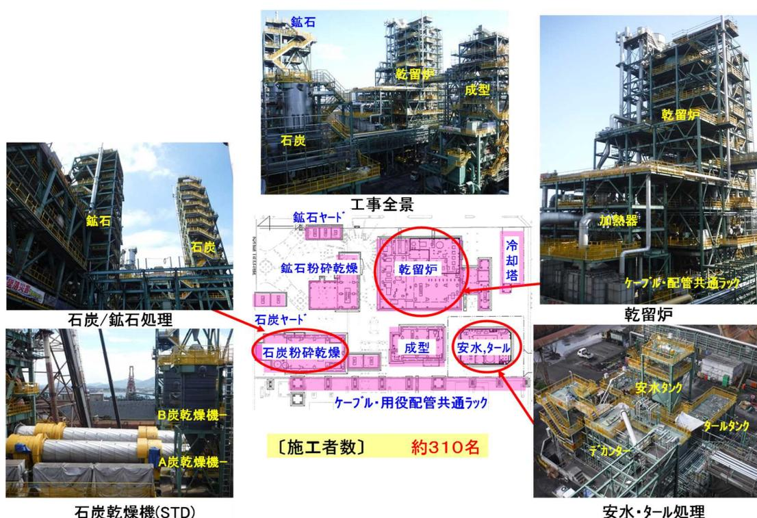
図3-3 300t/dフェロコックス製造中規模設備 工事全景
