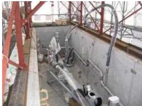
(2) 中間接続部側ヘリカル変形仮容器及び液体窒素供給ライン配管取付
