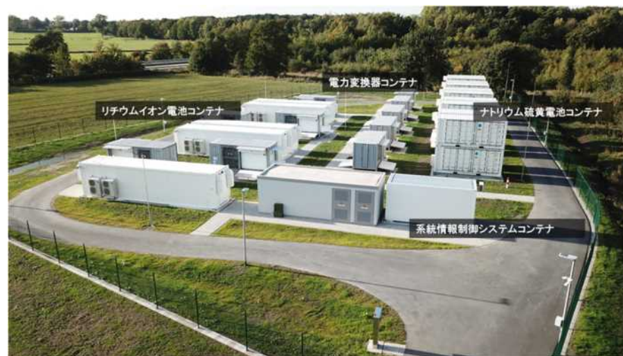
【写真】 ファール変電所におけるハイブリッド蓄電池システム外観
