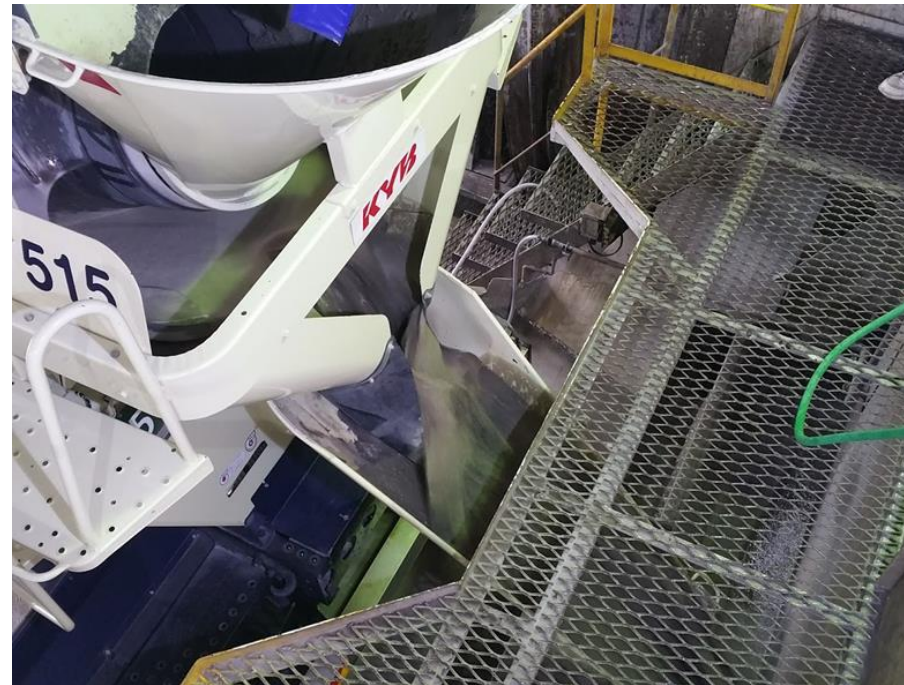
〔残コン等の溶解処理・設備の洗浄〕
