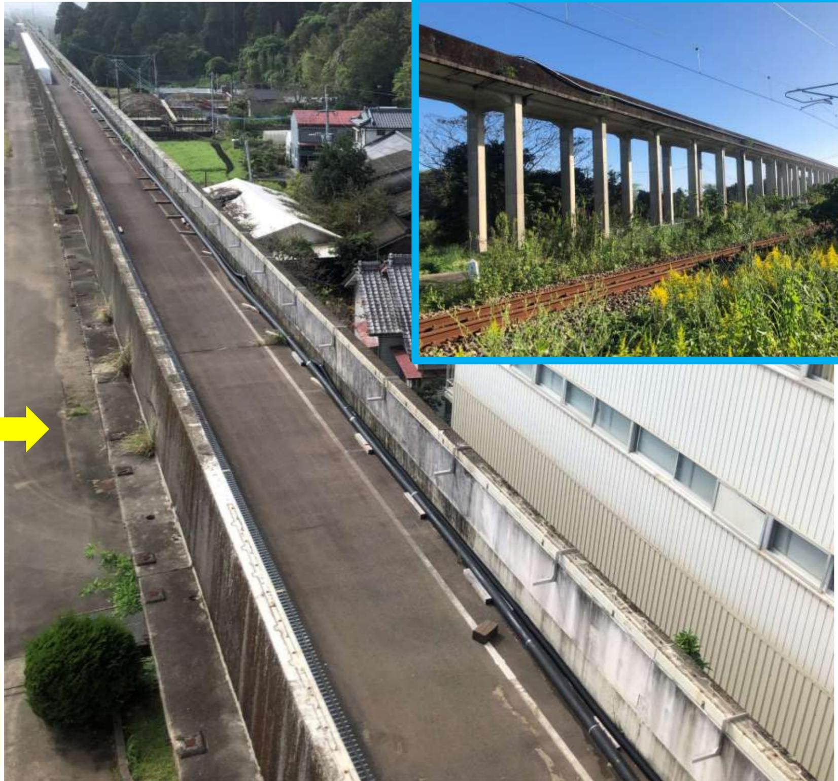
ガイドウェイ上に1.2 kmの断熱管を敷設し、**km級の冷媒圧送を実現**
