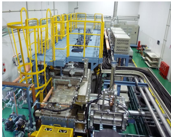
連続焼結設備
