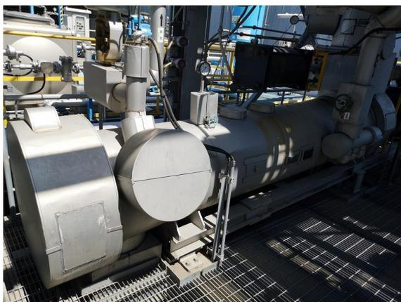
**図 2-2-6-2-5 反応槽**
