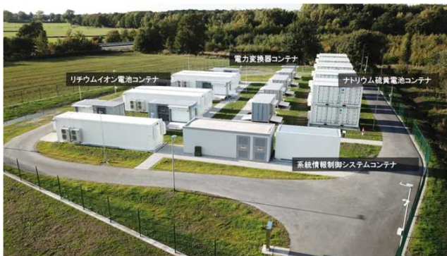
【写真】 ファーレル変電所におけるハイブリッド蓄電池システム外観
