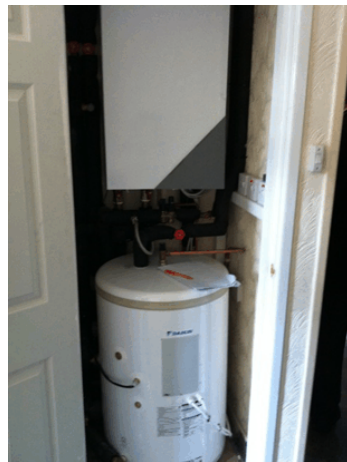
室内の温水タンクの様子
