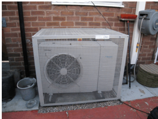
室外機の外観（盗難防止柵）
