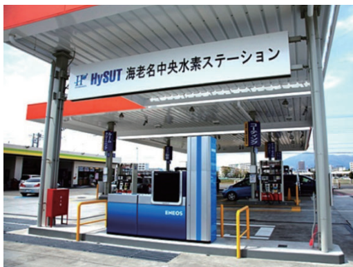
燃料電池車の普及に向け建設された、ガソリンスタンドと一体型の水素ステーション「海老名中央水素ステーション」
