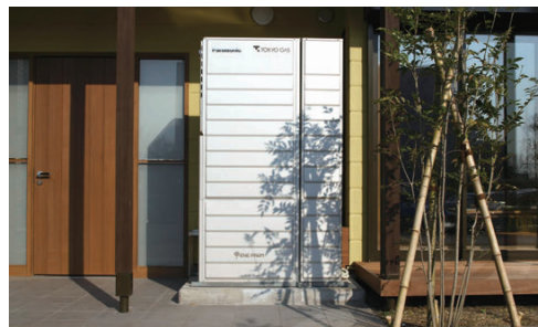
安全性評価や企業間の調整を経て商品化に成功した家庭用燃料電池システム「エネファーム」
