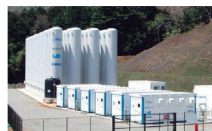
図31 ● 発電量の予測情報に基づく制御技術を用いた圧縮空気エネルギー貯蔵 (CAES: Compressed Air Energy Storage) システムの実証施設
