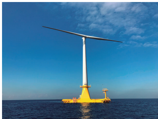
図12 ● バージ型浮体式洋上風力発電システム実証機
