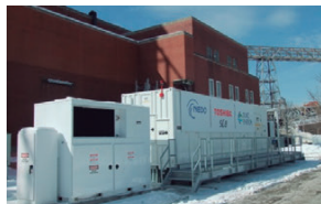
図8 ● 東芝エネルギーシステムズが開発したリチウムイオン電池・蓄電システム
