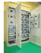
図9 ● 日立製作所・昭和電工マテリアルズが開発した鉛蓄電池-LICハイブリッド蓄電システム
