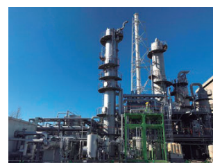
図26 ● 住友共同電力 新居浜西火力発電所(143t-CO 2 /日)
