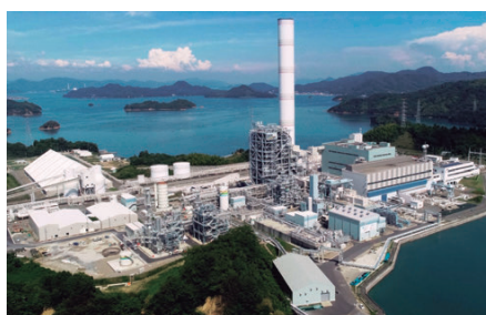
図3 ● 大崎クールジェンデモンストレーションプラント、大崎クールジェン(広島県大崎上島町) 石炭処理量 1,180t/日
