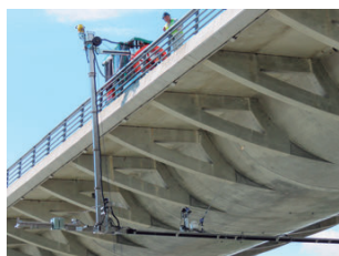
図7 ● 「インフラ維持管理・更新等の社会課題対応システム開発プロジェクト」実証実験の様子
