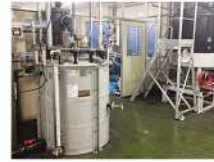
バナジウム回収パイロットプラント
