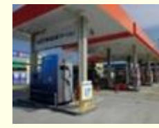
水素 ステーション
