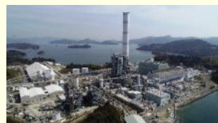
高効率火力発電所
