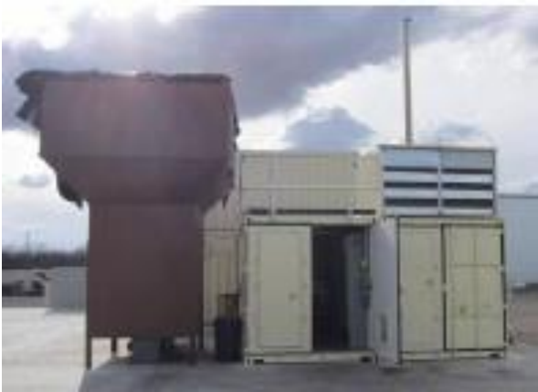
図 2.4.14 CPC 社 Biomax 100 ガス化ユニット（小型 CHP3 連の例）
