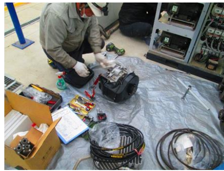
図 2.4.35 コンプレッサーメンテナンス状況
