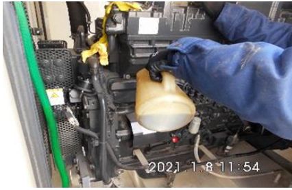
図 2.4.34 非常用発電機メンテナンス状況
