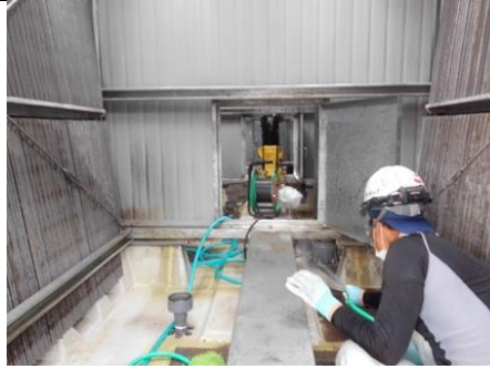
図 2.4.33 冷却水系統設備のメンテナンス状況
