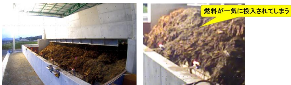
図 2.4.41 燃料過大時のウォーキングフロア
