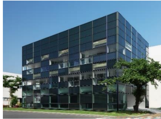
太陽光発電のビル壁面への設置
