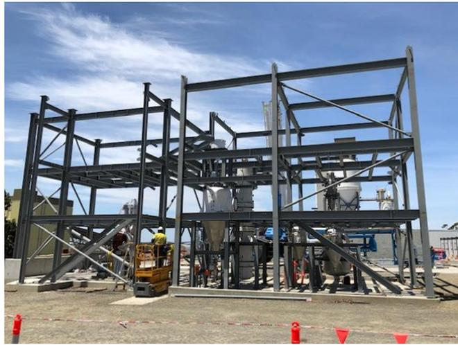
図 25 小型ガス化試験設備 建設状況（2020年1月）
