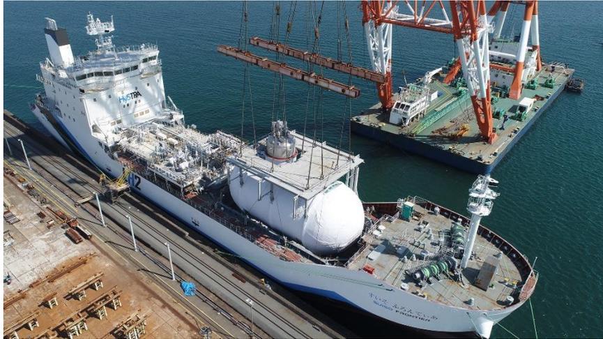
図 10 船体への本タンクシステム搭載作業時の様子
