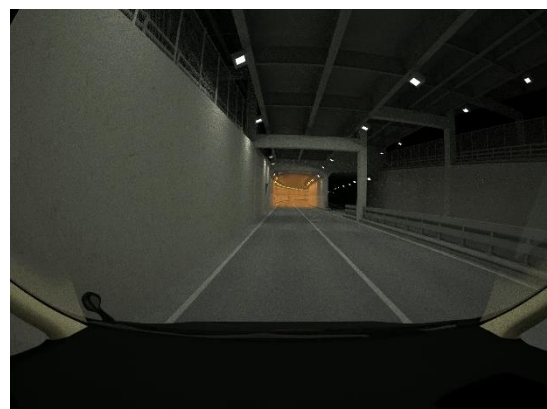
図 10 首都高 C1 トンネル
