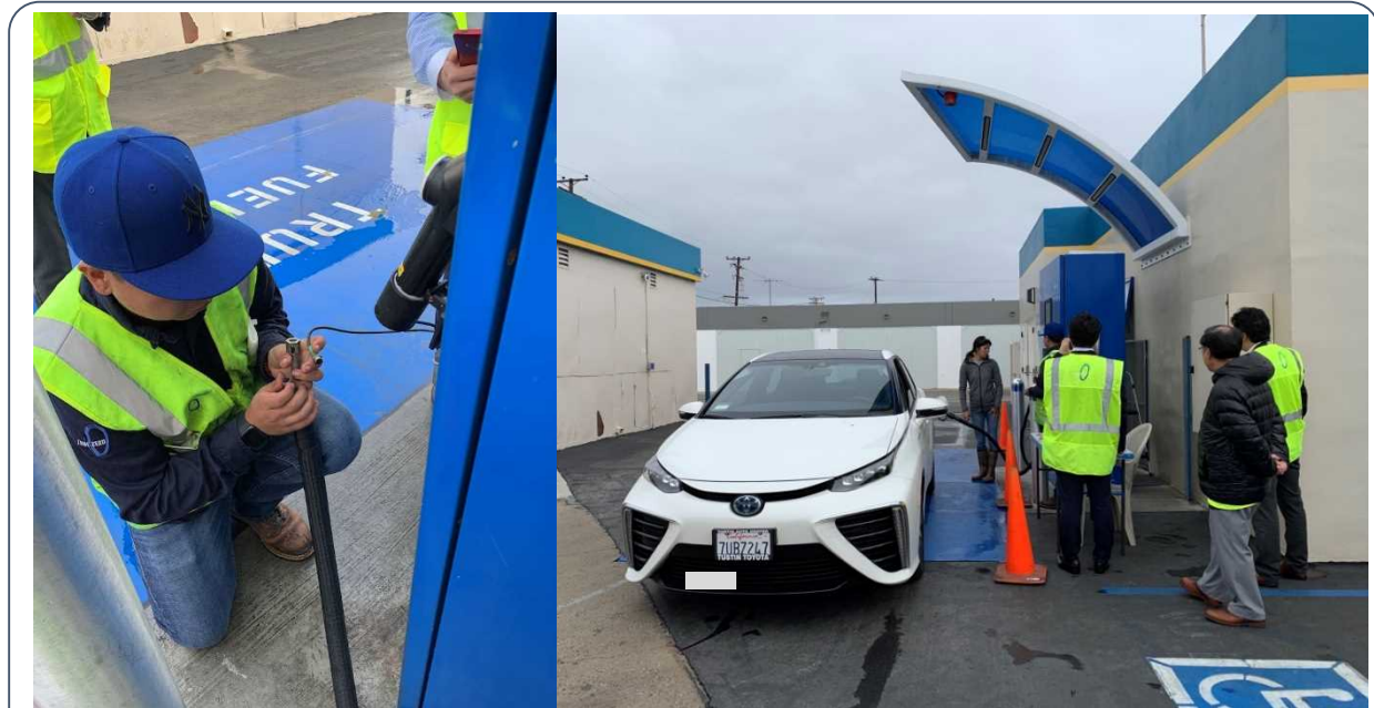
ホース取り付け作業
