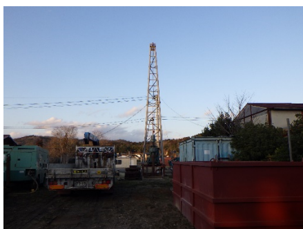
図Ⅲ (3. 1)-3 大深度地中熱交換器施工風景 (三次市)・設置した大深度地中熱交換器 (札幌市) により測定した自然地中温度分布
