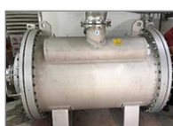
スパイラル式熱交換器 (互太) ※中国への導入は初
