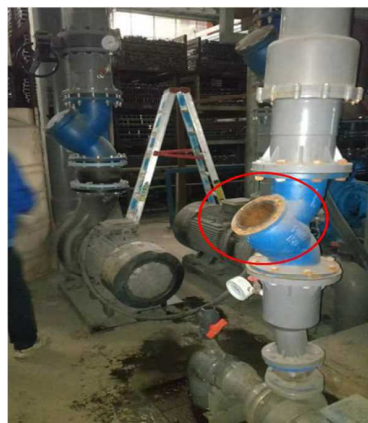
ターボ冷凍機 フィルター清掃（左）、キャップを外してのストレーナー内部清掃（右）
