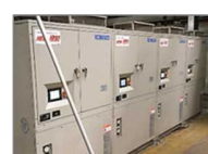
冷温同時取出 ヒートポンプ (華昌) ※中国への導入は初
