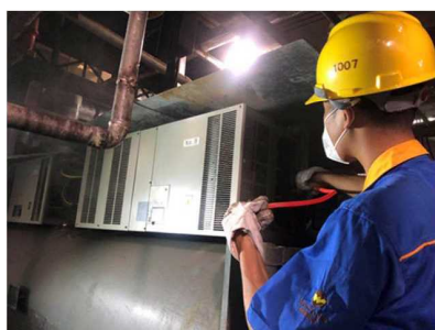
ターボ冷凍機 フィルター清掃（左）、キャップを外してのストレーナー内部清掃（右）
