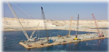
オマーンで建設中のプラント
