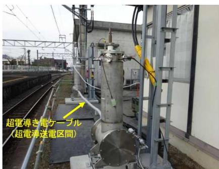
写真1 敷設した超電導き電ケーブル
