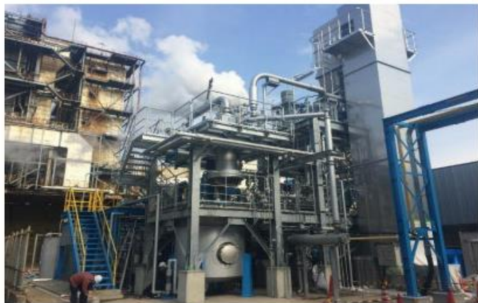
パイロットプラント外観
