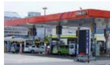
2012年 商用モデル実証水素ステーションを建設
