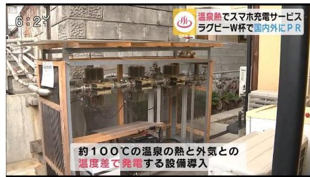
別府地域でのモバイル機器充電, LED照明等を目的とした温度差発電ユニットの設計・製作・評価を継続する。温度差発電による年間20kWh以上の発電が可能であることを実証
