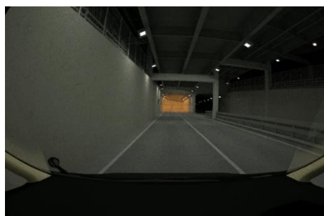
図7 首都高C1トンネル
