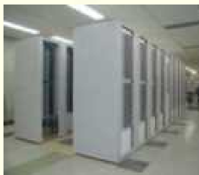
データセンター
