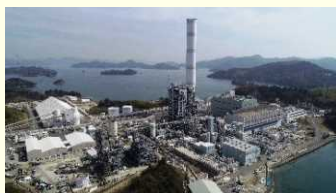
高効率火力発電所
