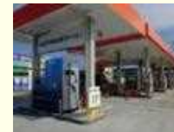
水素 ステーション
