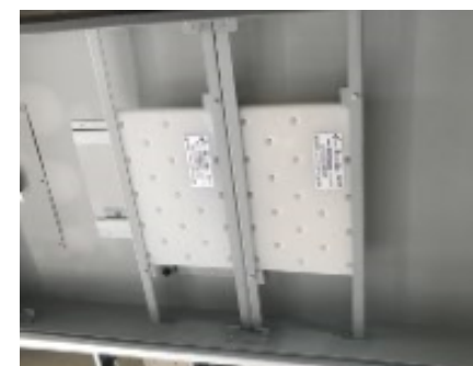
蓄熱材(放射パネル内部に設置)
