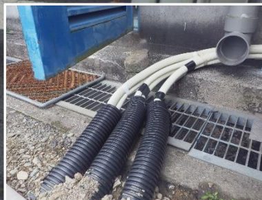
電線配線用埋設FEP管
