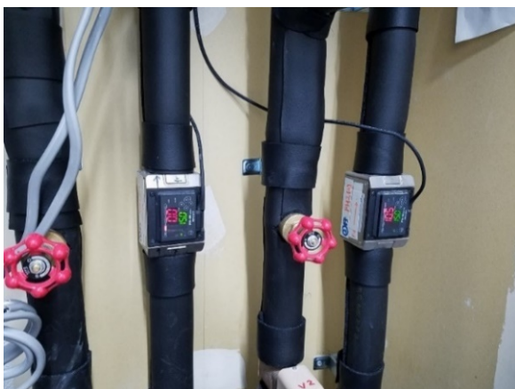
放射空調冷温水配管(流量計)
