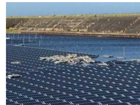
例：水上型における破損
