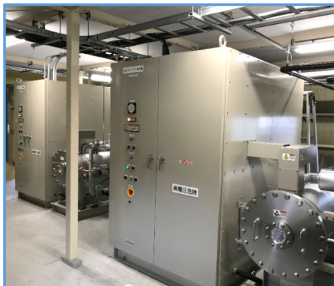
プラズマオゾン発生装置 (奥:O 3 4 kg/h、手前:O 3 6 kg/h)
