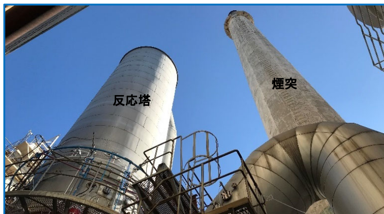
実機NO x 低減処理設備(反応塔と煙突)
