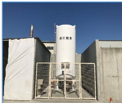
酸素供給設備 3500 m 3 CE(cold evaporator)タンク
