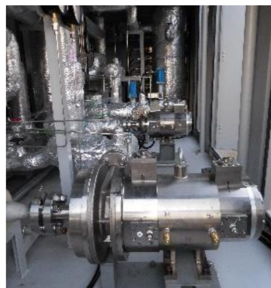
試作機設置時の外観
