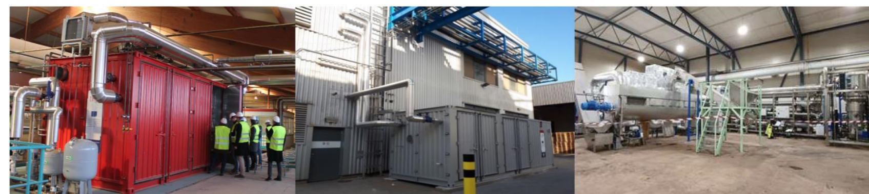
Wienerverger社 レンガ乾燥工程に導入された 閉ループヒートポンプ Agrana社 でんぷん乾燥工程に導入された 閉ループヒートポンプ Scanship社 生物汚泥乾燥工程に導入された 開ループヒートポンプ
