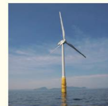
世界初のハイブリッドスパー型浮体式洋上風力発電
