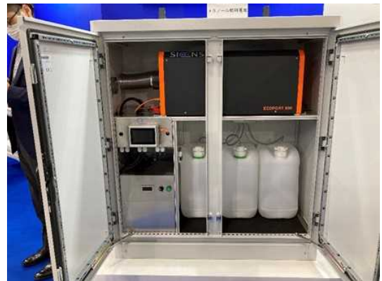
写真 2：Siquens 社の燃料電池発電システム
