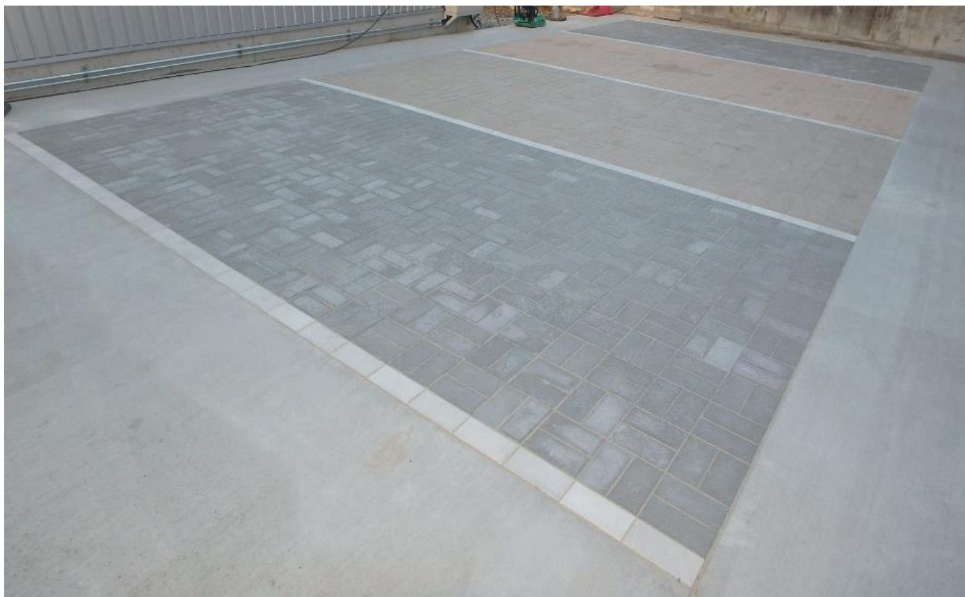
敷設したインターロッキングブロック (手前から普通ブロック市販品、普通ブロック実証製造品、 透水ブロック実証製造品、透水ブロック市販品)
