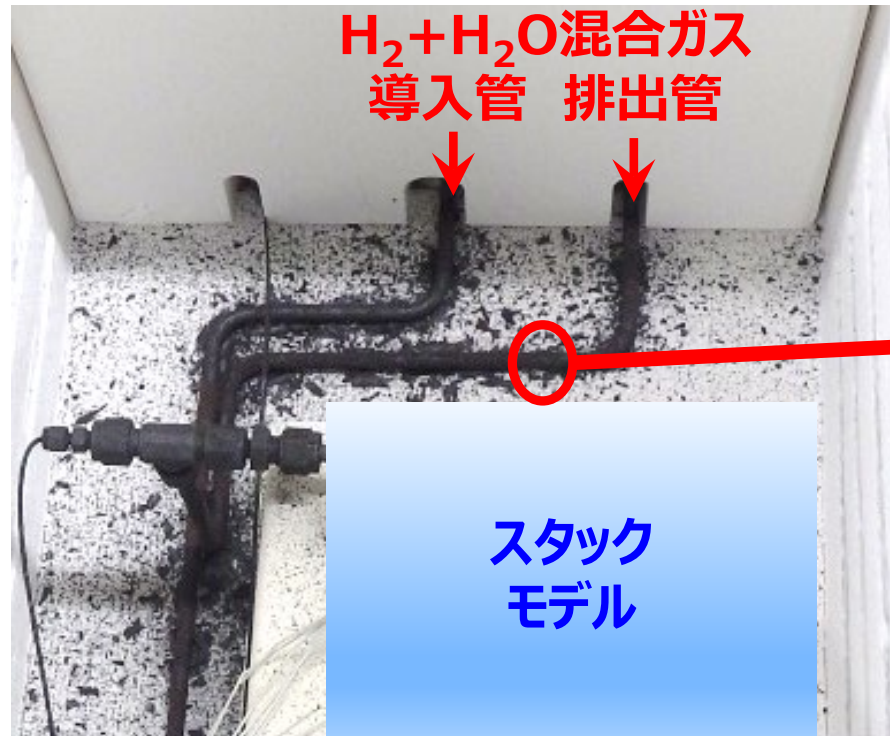
運転試験後のスタック導入・排出配管外観
